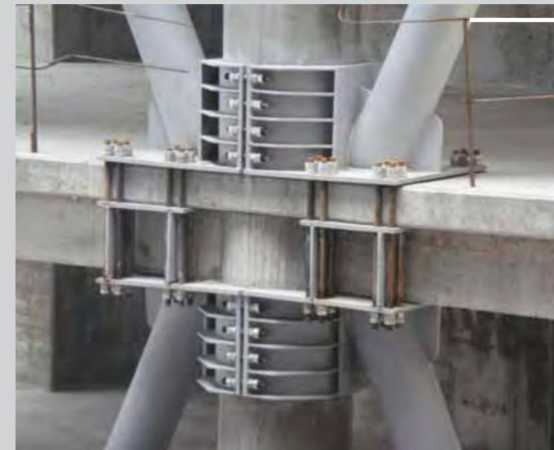
• Inel metalic fixat cu șuruburi de înaltă rezistență
